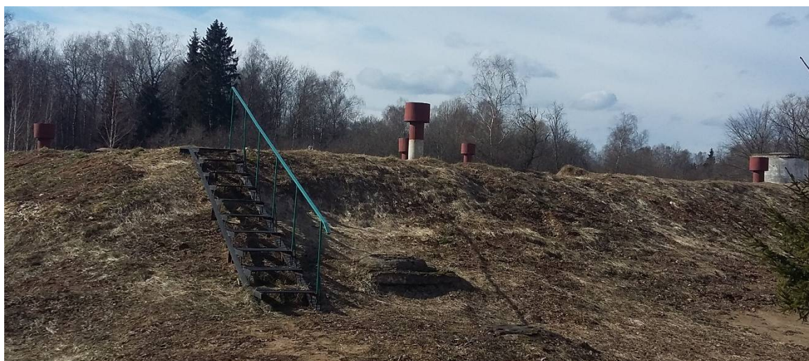
Рисунок 1.9 – Общий вид надземной части резервуаров чистой воды водозабора Верхне-Гжатский
