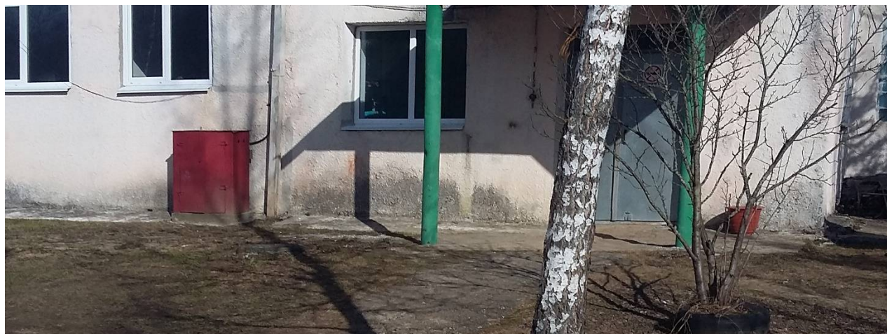
Рисунок 1.30 – Общий вид здания насосной станции второго подъема и станции очистки водозабораВерхне-Гжатский
