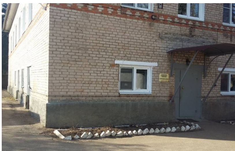
Рисунок 1.10 – Общий вид здания станции очистки водозабора Центральный
