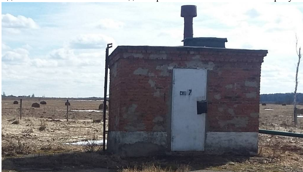
Рисунок 1.2 – Общий вид павильона скважины №7 водозабора Столбовский
