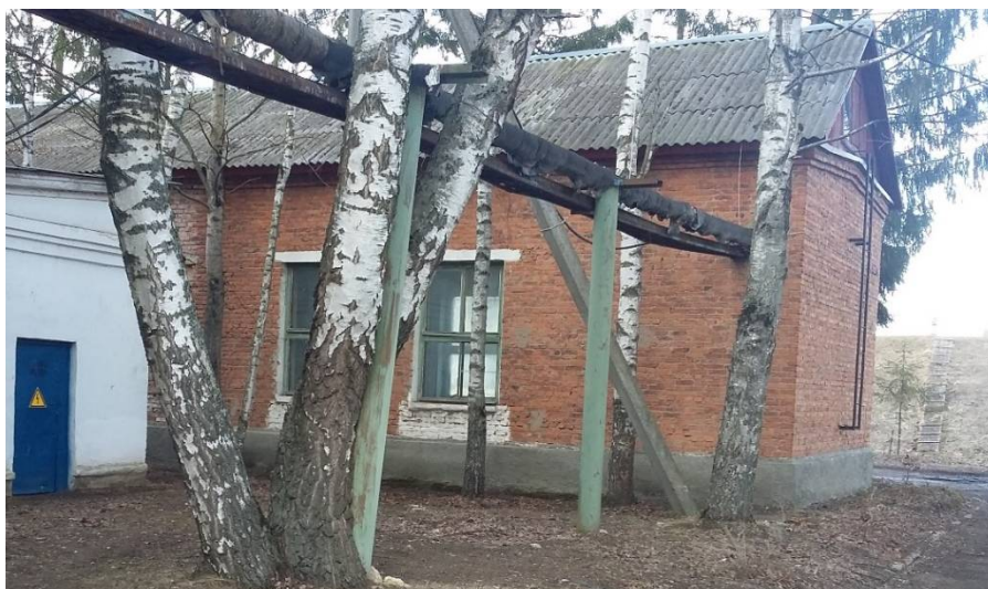
Рисунок 1.27 – Общий вид здания станции втого подъема водозабораЦентральный
