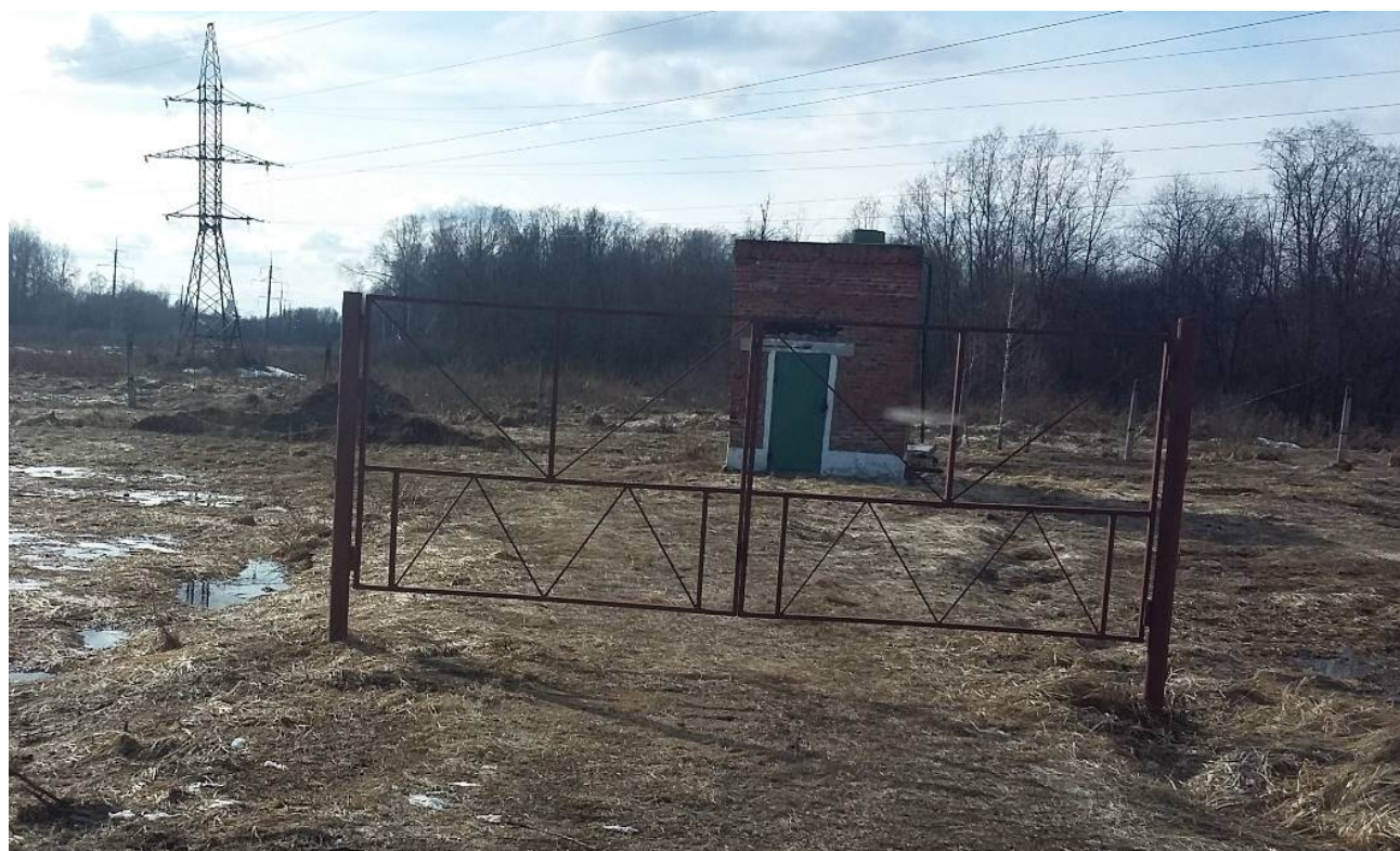
Рисунок 1.7 – Общий вид 2 павильона скважины водозабора Верхне-Гжатский
