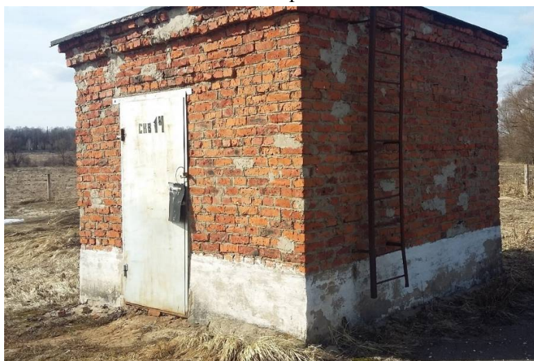
Рисунок 1.3 – Общий вид павильона скважины №14 водозабора Столбовский
