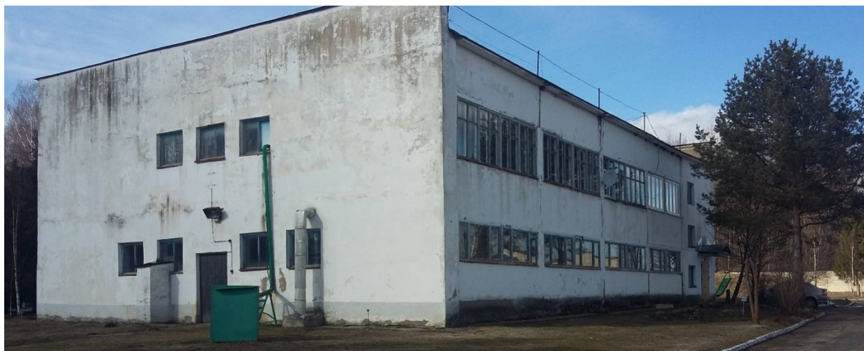
Рисунок 1.28 – Общий вид здания насосной станции второго подъема и станции очистки водозабора Столбовский
