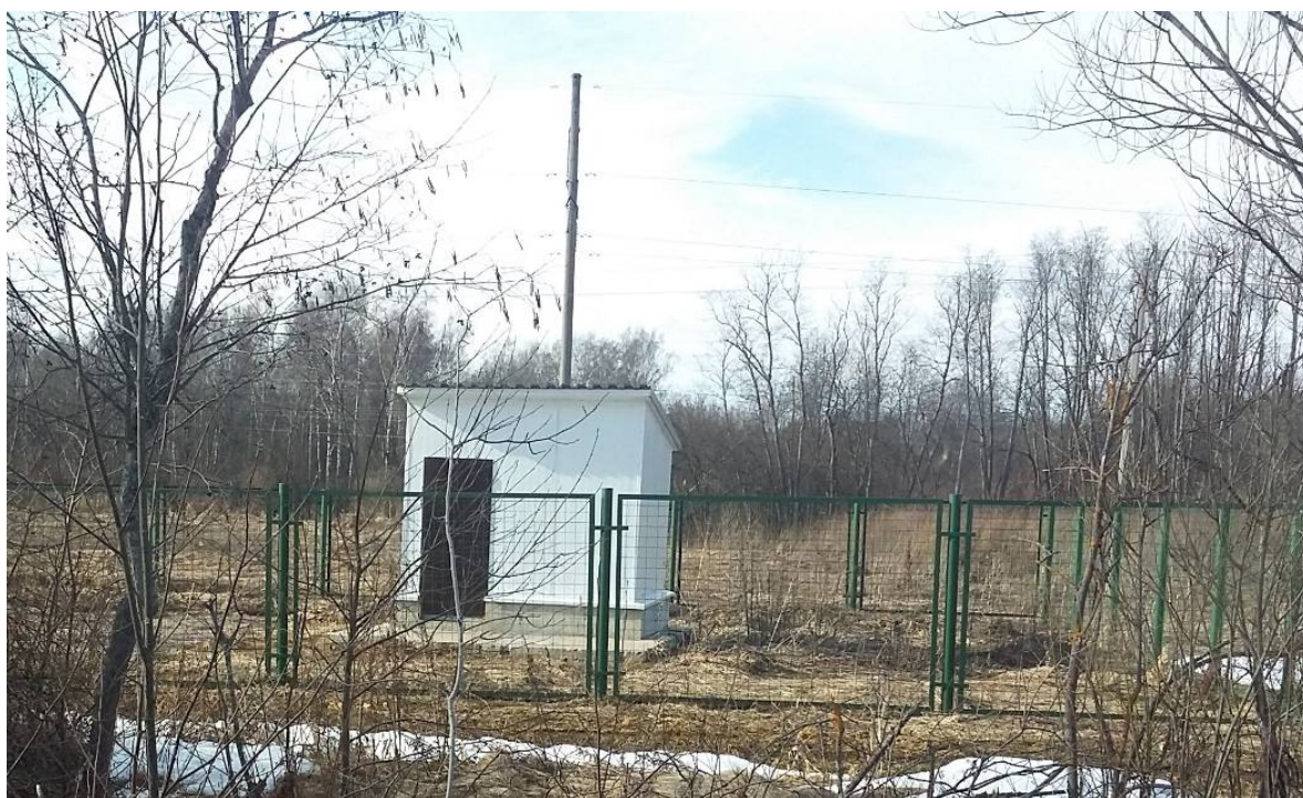
Рисунок 1.8 – Общий вид 3 павильона скважины водозабора Верхне-Гжатский
